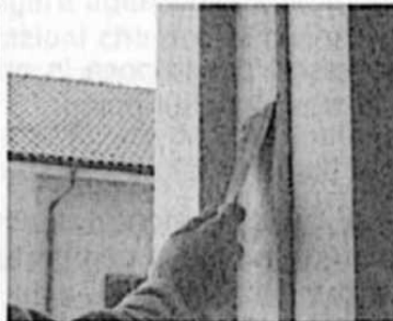
ΦΑΣΗ 2: Καθαρισμός υπολειμμάτων σοβά και κάλυψη ψευδοπλασίων.
