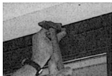
ΦΑΣΗ 10: Τοποθέτηση καλυμμάτων.
