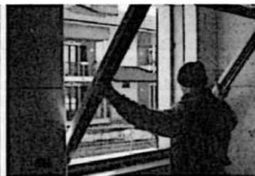
ΦΑΣΗ 5: Τοποθέτηση πλαισίου.
