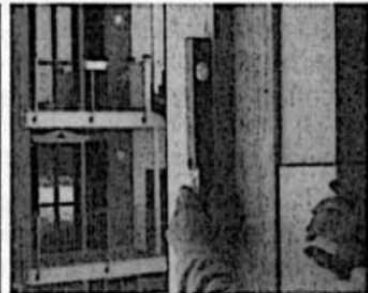
ΦΑΣΗ 3: Έλεγχος καθετότητας κουφωμάτων.
