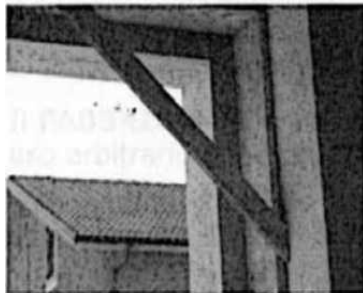
ΦΑΣΗ 1: Έλεγχος ακεραιότητας και στερέωσης ψευδών πλαισίων.
